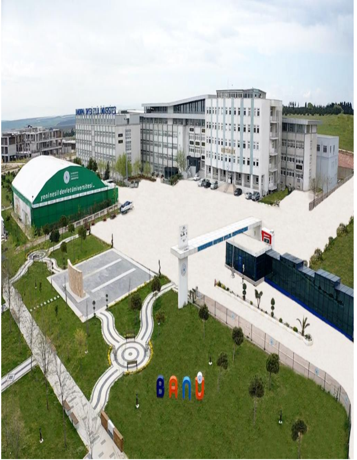
Resim 1- Rektörlük Merkez Yerleşkesi
