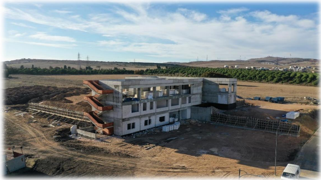
Resim 11- Merkezi Araştırma Laboratuvar Binası
