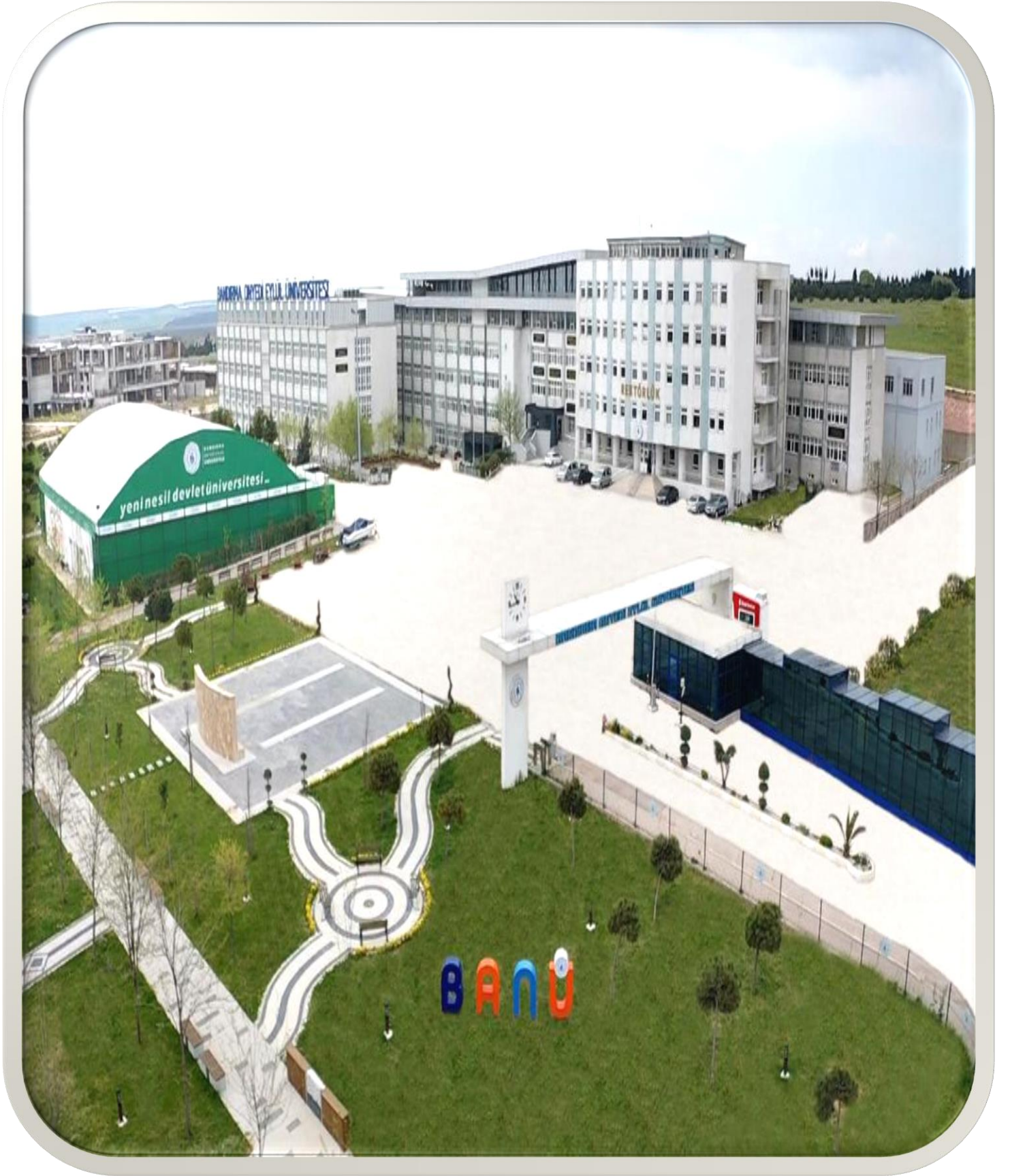
Resim 1- Rektörlük Merkez Yerleşkesi
