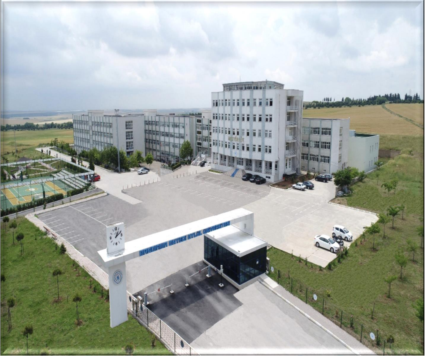
RESİM-1- Rektörlük Merkez Yerleşkeden Bir Görüntü
