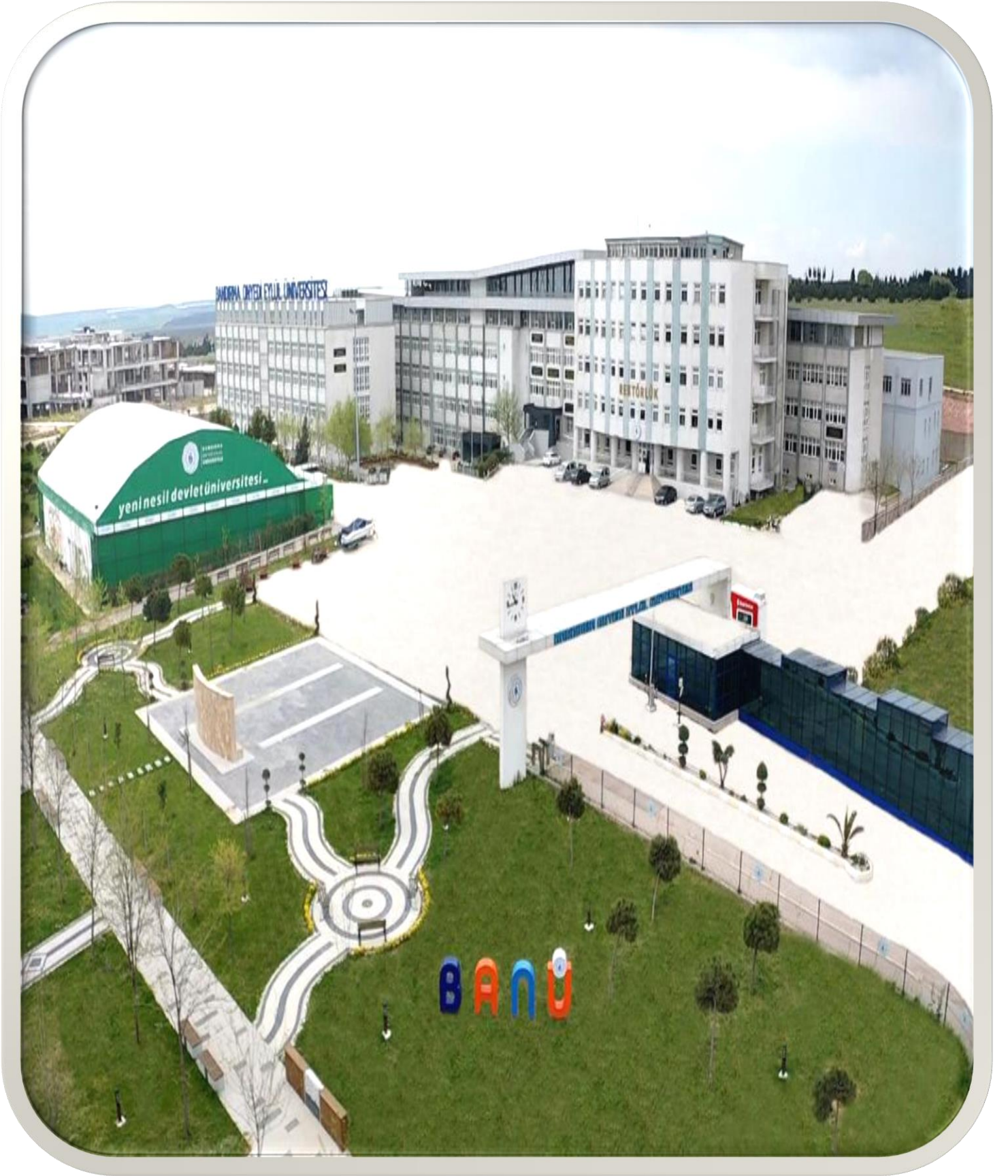
Resim 1- Rektörlük Merkez Yerleşkesi
