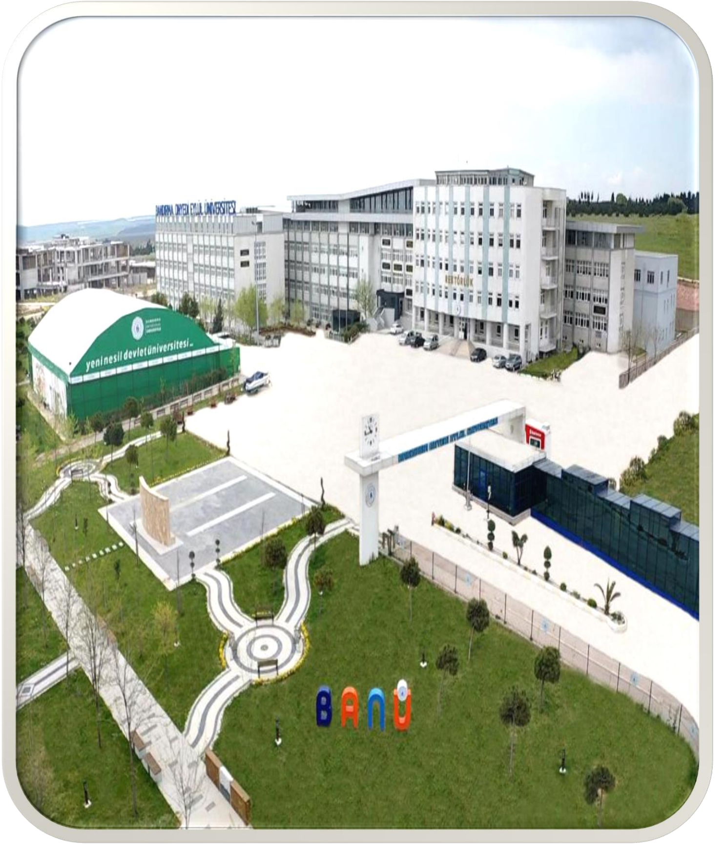
Resim 1- Rektörlük Merkez Yerleşkesi
