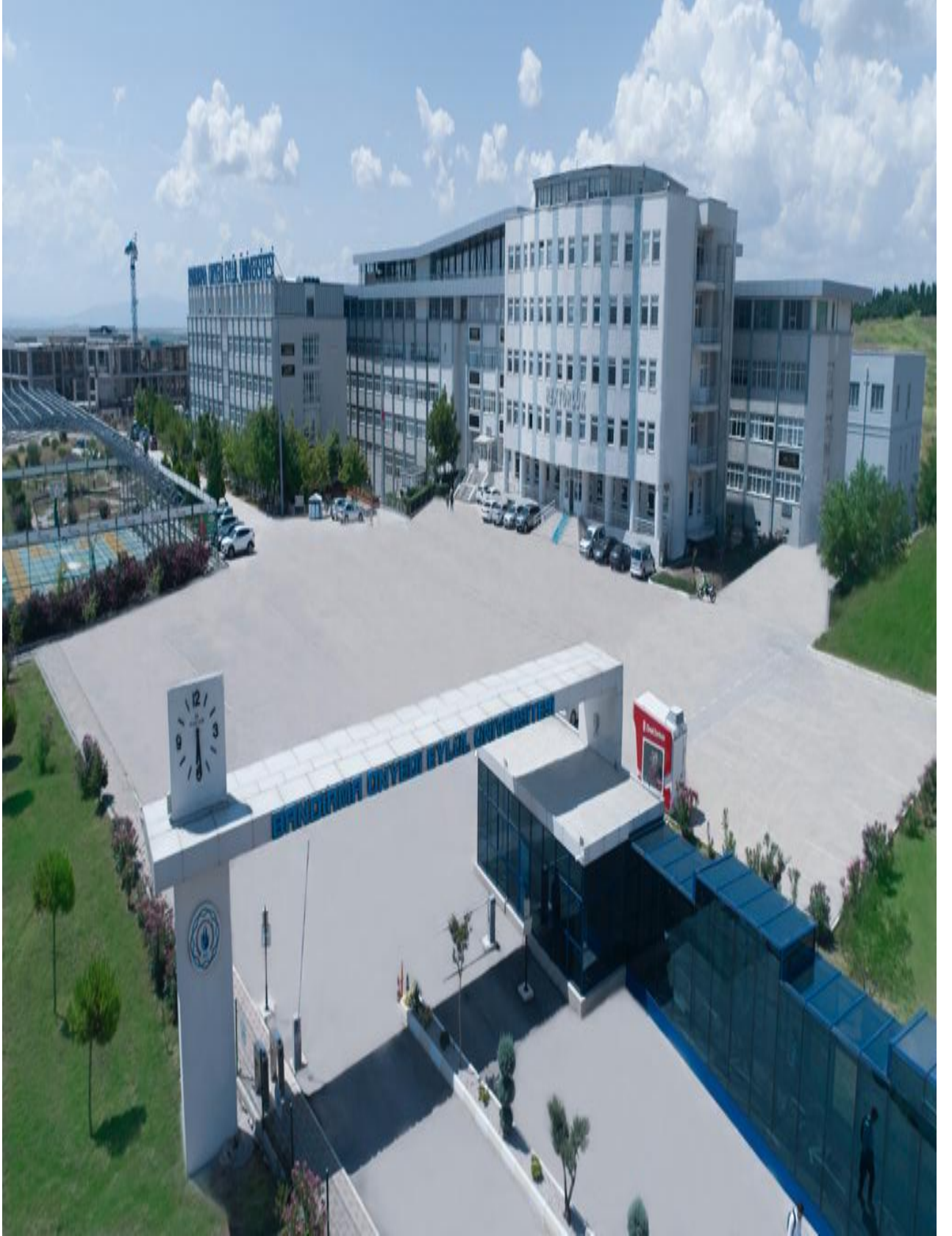
Resim 1- Rektörlük Merkez Yerleşkesi
